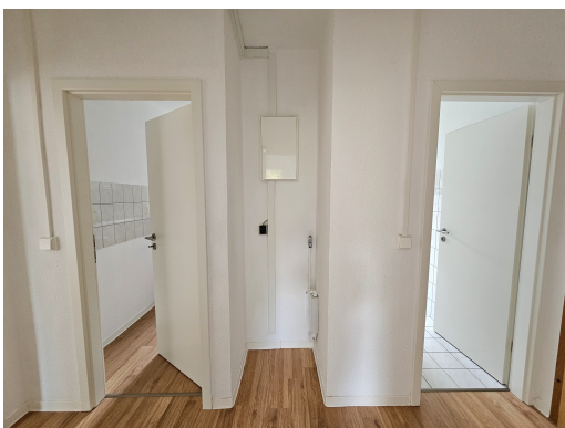
Waschmaschinenanschluss im Flur
